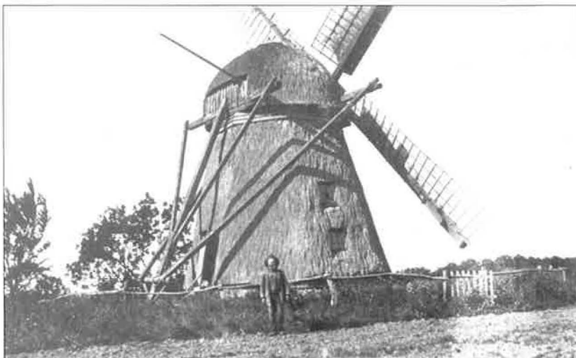
Havnø Mølle ca. 1900. Bemærk Krøjeværkets konstruktion.
