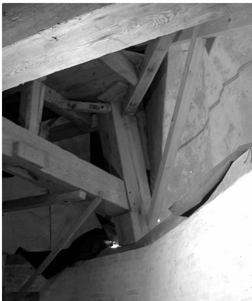
Den besynderlige konstruktion, hvorved gulvet er ”løftet” over bjælkelaget.
